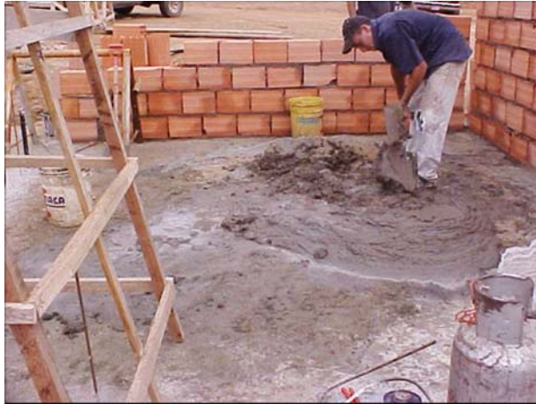
CONSTRUCCION TRADICIONAL CON LADRILLO
